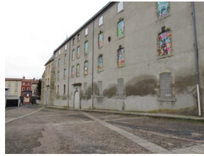
Lado este del edificio
