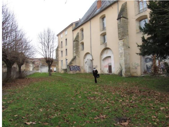
Parte oeste del edificio y supuesta ubicación del cementerio
