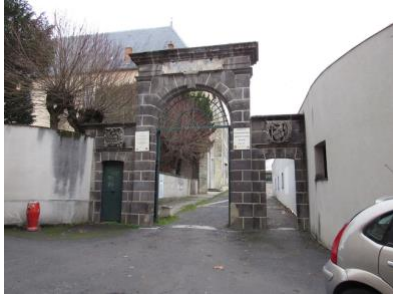
Puerta de entrada al campus
