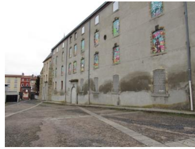
Côté est du bâtiment
