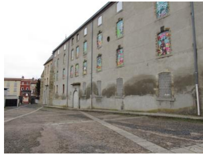
Lato est dell'edificio
