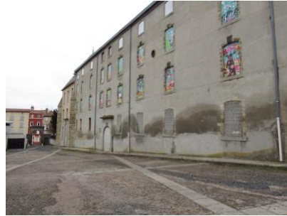
Lado leste do prédio
